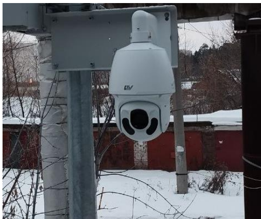
Установка камер видеонаблюдения
