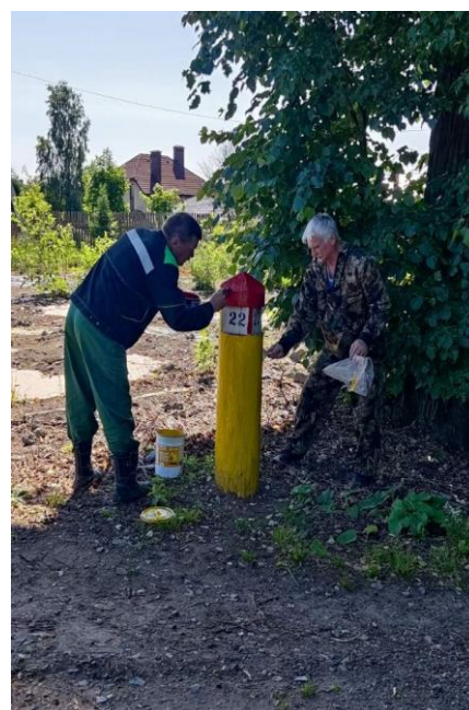
Установка квартальных столбов
